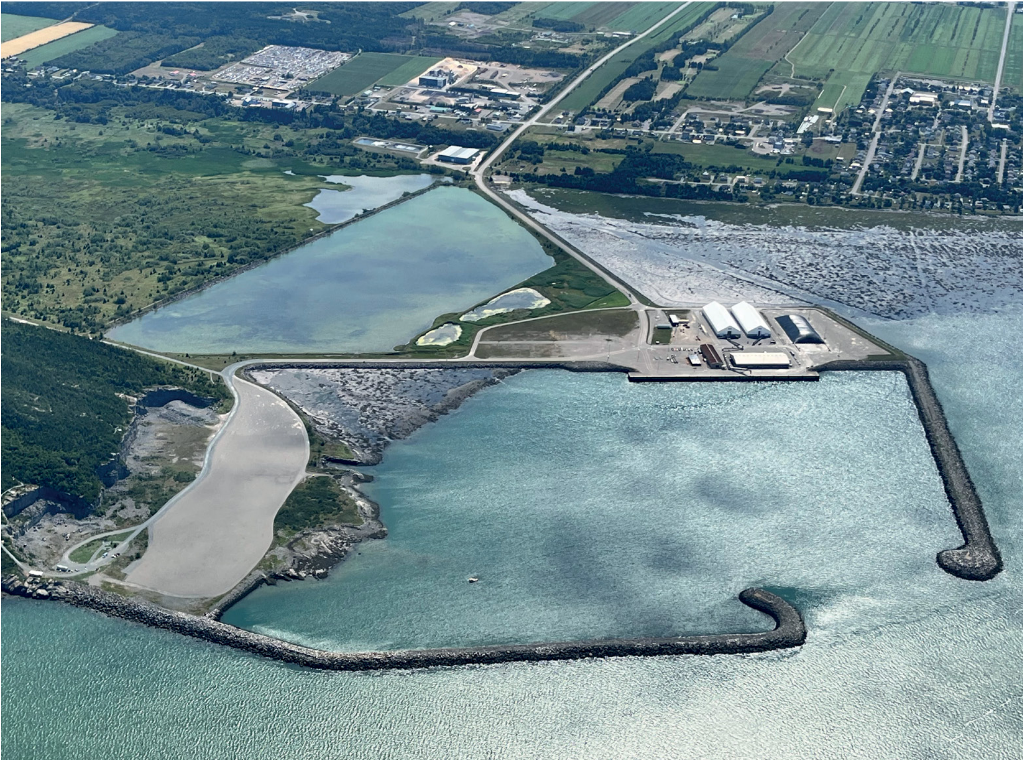
Figure 12 : Vue aérienne du port de Gros-Cacouna
